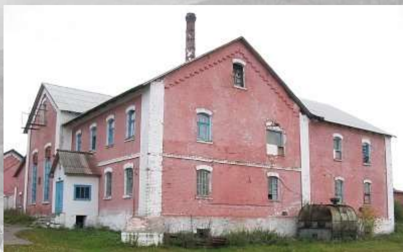
Здание спиртозавода в д. Больково
